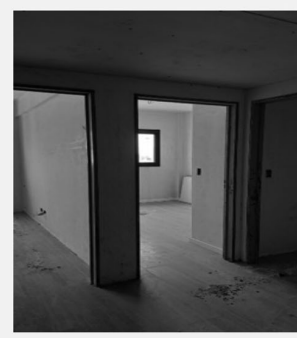
ESTADO DE DEPARTAMENTOS EN 7° PISO.
