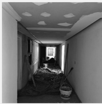
PASILLOS DE CIRCULACION 6° PISO.
