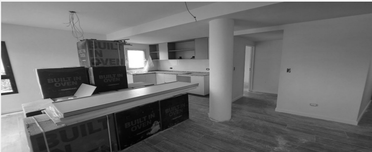
TERMINACIONES EN COCINAS - ACOPIO DE HORNOS ELECTRICOS.
