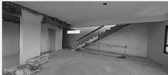
TERMINACIONES DE PISOS Y YESO.
