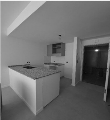
ESTADO DE DEPARTAMENTOS EN 3° PISO.
