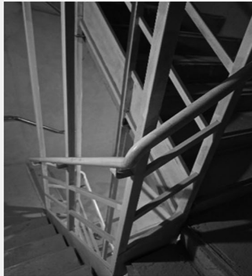
BARANDAS EN ESCALERA PRINCIPAL.
