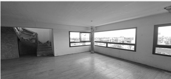
TERMINACIONES DE PISOS Y YESO.
