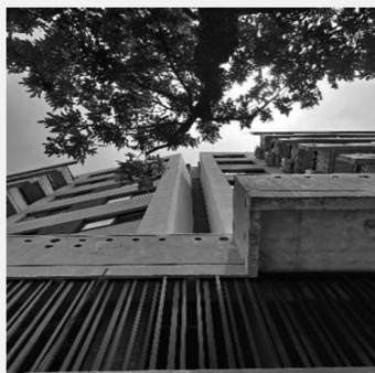
FACHADA PLANTA BAJA.
