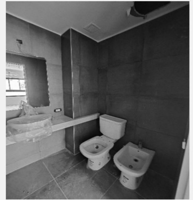
ESTADO DE DEPARTAMENTOS EN 4° PISO.
